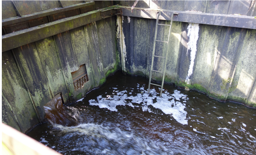
Abbildung 4: Schütz im Bahndamm, fotografiert von unterstrom
