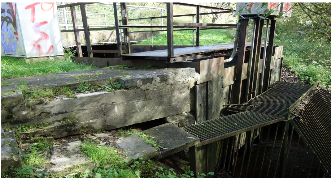
Abbildung 7: Staubauwerk mit Schütz vor dem Bahndamm
