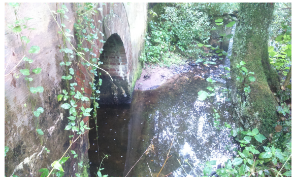
Abbildung 3: Durchlass im Bahndamm, fotografiert von unterstrom
