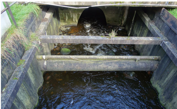
Abbildung 2: Durchlass im Bahndamm, fotografiert von oberstrom
