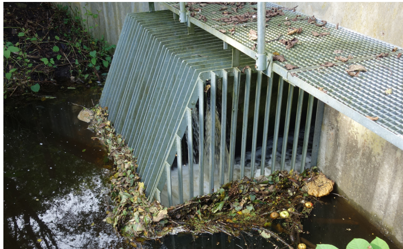
Abbildung 8: Rechen vor dem Durchlass unter der Husumer Straße und Beginn der Verrohrung, fotografiert von oberstrom
